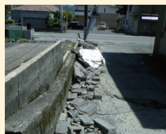
ブロック塀の倒壊
