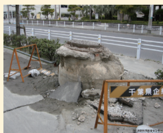
液状化によるマンホールの浮き上がり
